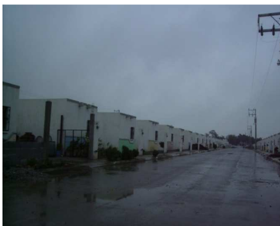
FOTO: Conjunto habitacional al sur de Ciudad Mante.
