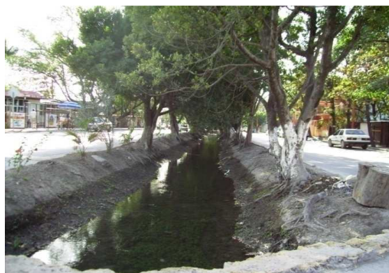
FOTO: Canal de riego distrito 002 en zona urbana.
