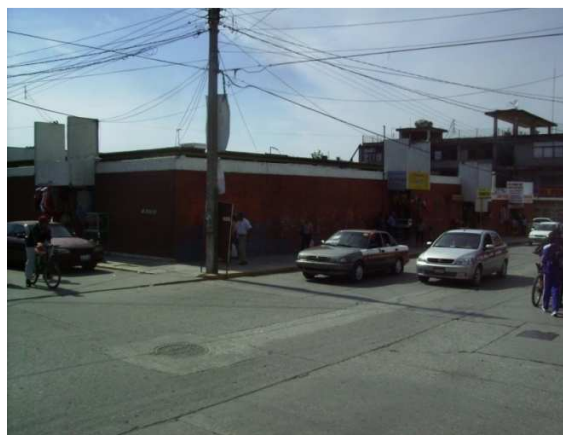
FOTO: Mercado Municipal en zona centro.
