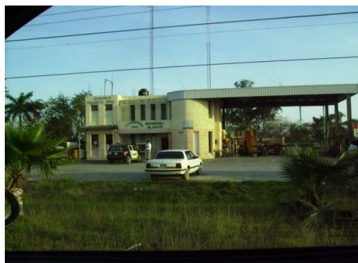
FOTO: Estación de bomberos sobre carretera El Mante-Cd. Valles.
