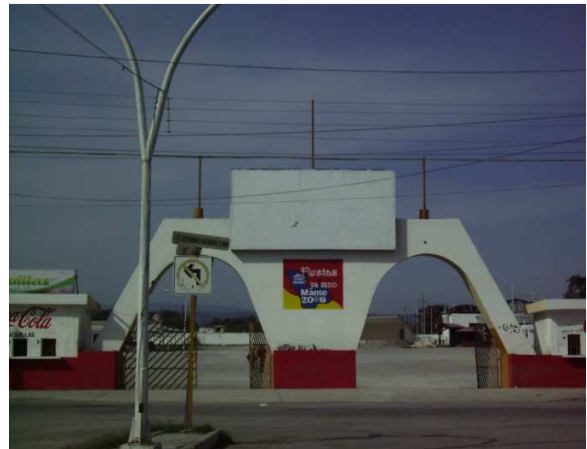
FOTO: Instalaciones de la feria y usos múltiples
