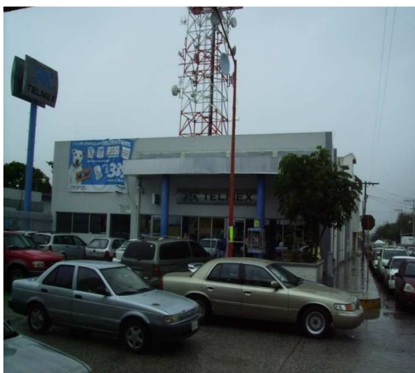
FOTO: Tienda y oficinas de TELMEX en la cabecera municipal.
