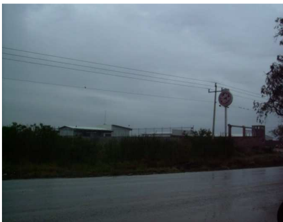
FOTO: Planta distribuidora de leche pasteurizada
