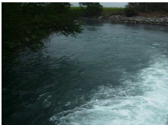
FOTO: Canalización de aguas hacia el río Mante.
