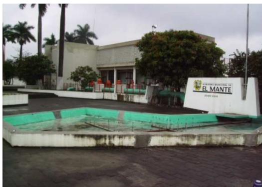
FOTO: Planta potabilizadora Mante II
