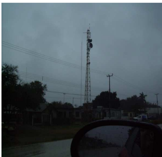
FOTO: Torre repetidora de señal en la localidad El Limón.
