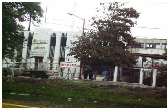
FOTO: Planta Potabilizadora Mante I.
