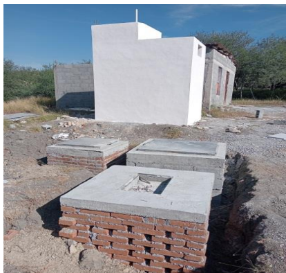
Construcción de sistema de drenaje por medio de biodigestor.
