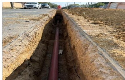
Suministro e instalación de tubería de P.V.C.
