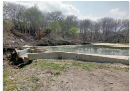
Fuente de abastecimiento y galería filtrante
