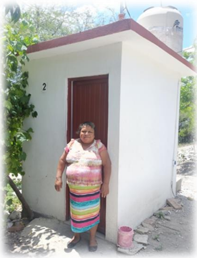
Beneficiada de obra de "Saneamiento básico mediante biodigestor que incluyó caseta (baño digno)", en la localidad de Plan de Ayala, municipio de Jaumave, Tamaulipas.
