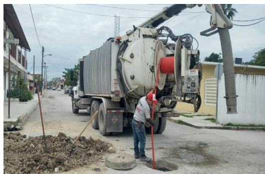
Desazolve de atarjeas en la cabecera municipal de Soto La Marina, Tamaulipas.
