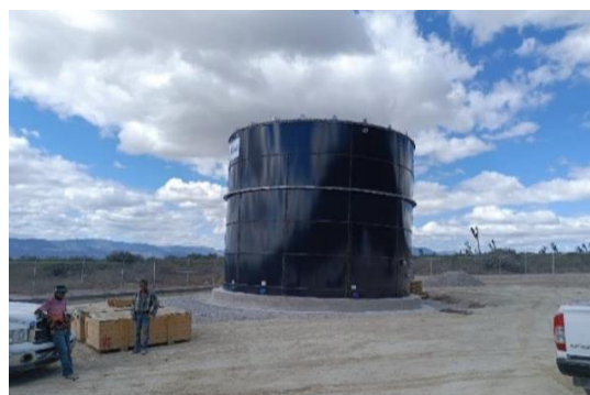
Tanque de almacenamiento de sistema múltiple Caudillos del Sur – Santo Tomás, Cieneguillas – Francisco I. Madero – San Pedro – Los Charcos, en Tula, Tamaulipas
