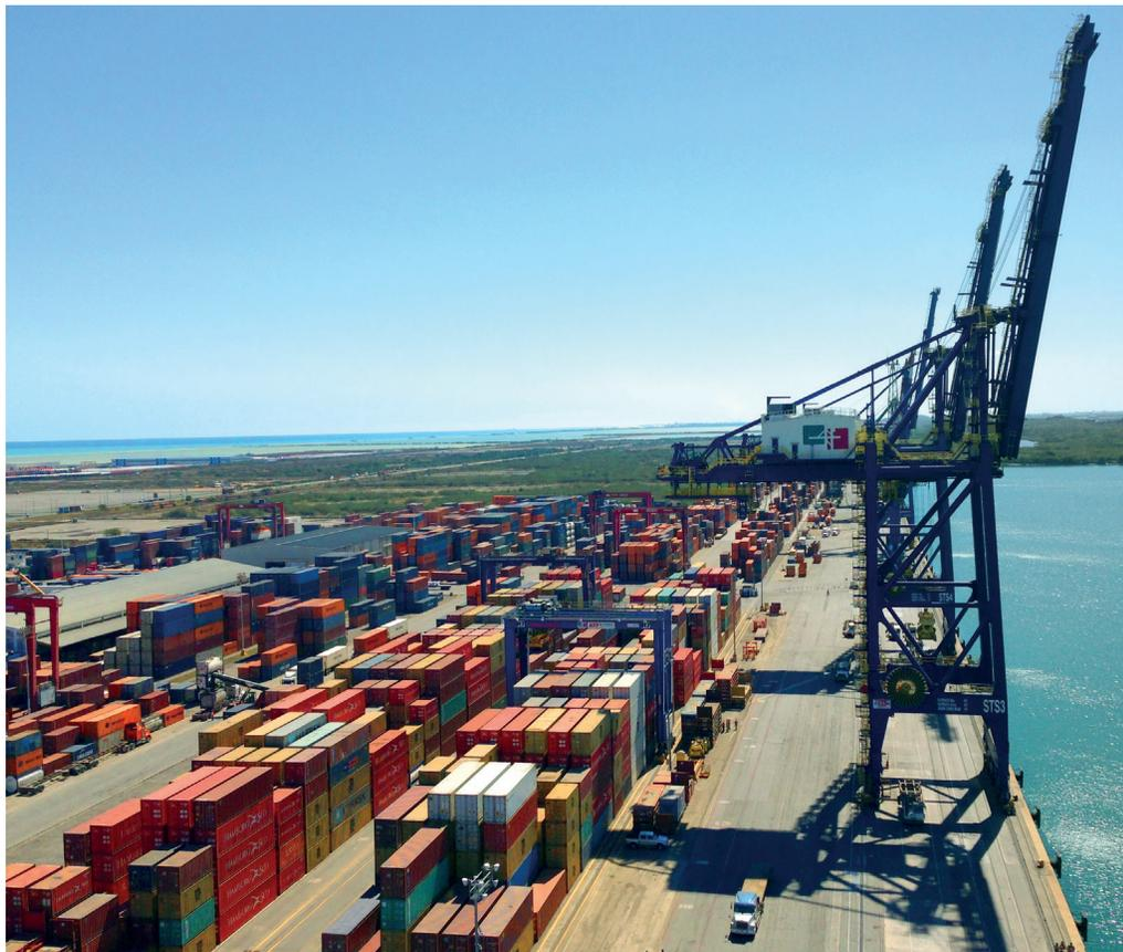
Con una profundidad de 12.19 metros el puerto de Altamira cuenta con 13 terminales de operación y 19 posiciones de atraque, equipadas para servir a una gama de cargas diversas: fluidos petroquímicos, carga contenerizada, carga general suelta, granel mineral y granel agrícola; y próximamente fluidos petrolíferos.
