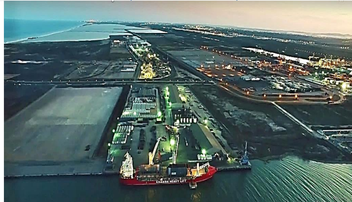
ILUSTRACIÓN 1. Vista parcial de Puerto de Altamira y reserva territorial
