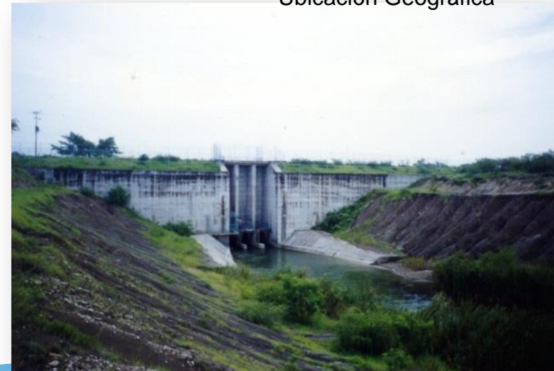
Obra de toma Presa Presidente Lic. Emilio Portes Gil.
